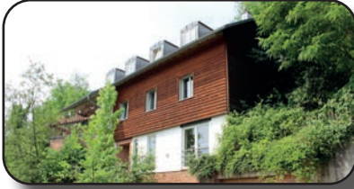
RENOVIERUNG DES PFARRHAUSES
